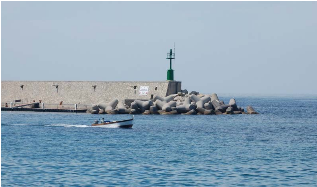
Dettaglio della testata della diga foranea
