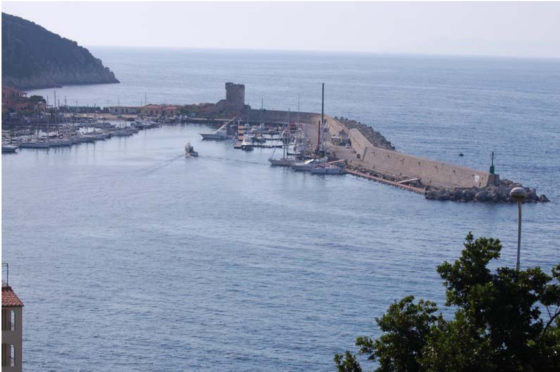
La diga foranea del porto di Marciana Marina
